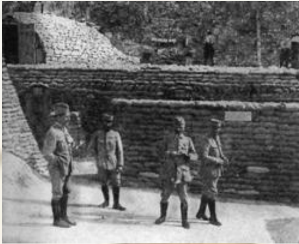
Французские оборонные сооружения, Сомма, 1916 г.
